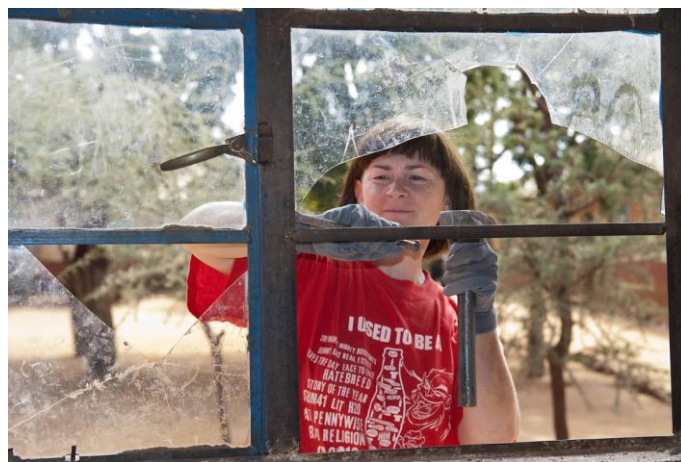
Oude, gebroken, ruiten moesten worden verwijderd en de fitting proper gemaakt.
